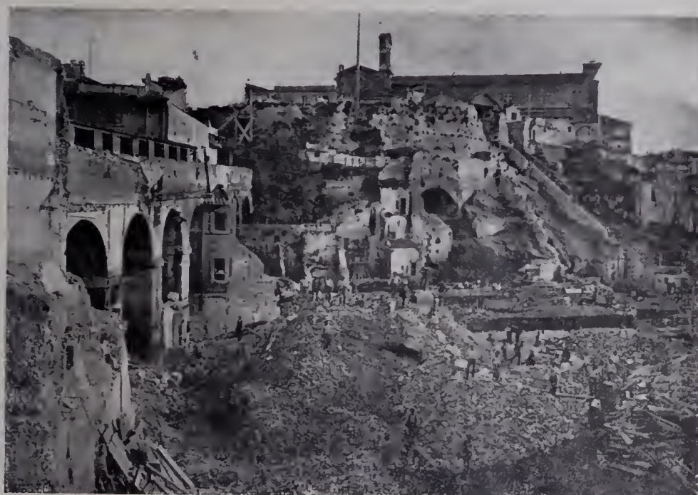
78. — Sbancamento del Colle Capitolino. Cantiere inferiore
